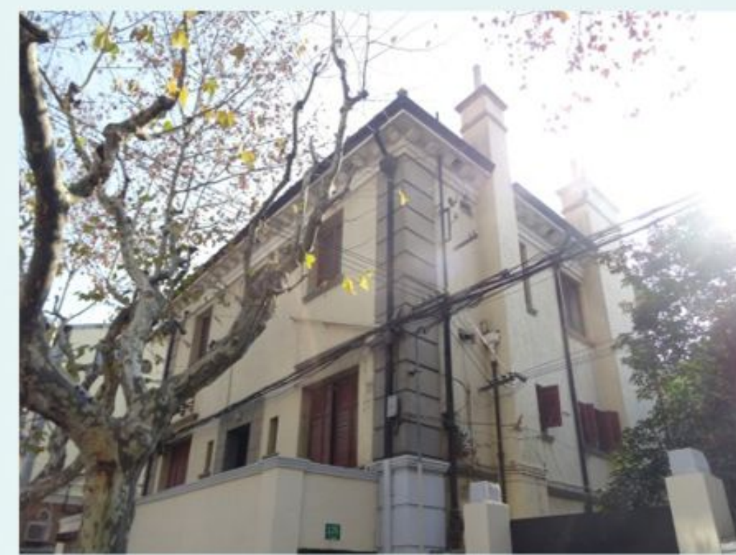
▲ 延庆路135号·优秀历史建筑修缮工程
