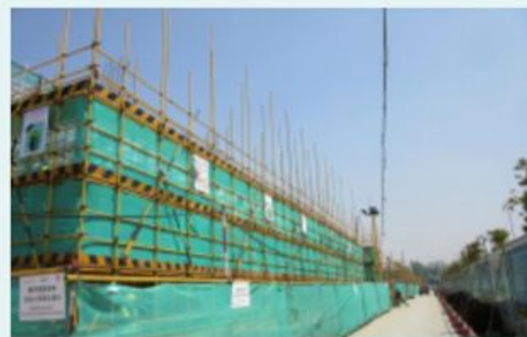
图2脚手架分段使用
