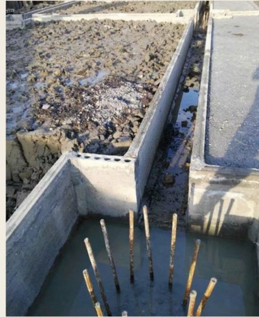
图1 承台基础梁处
