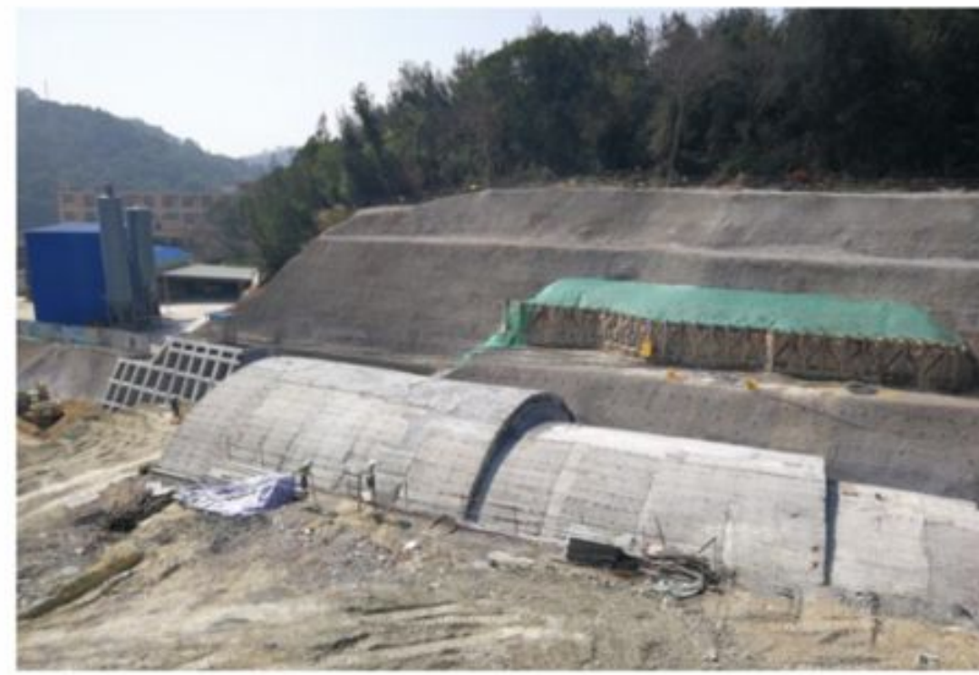
盖挖段施工效果
