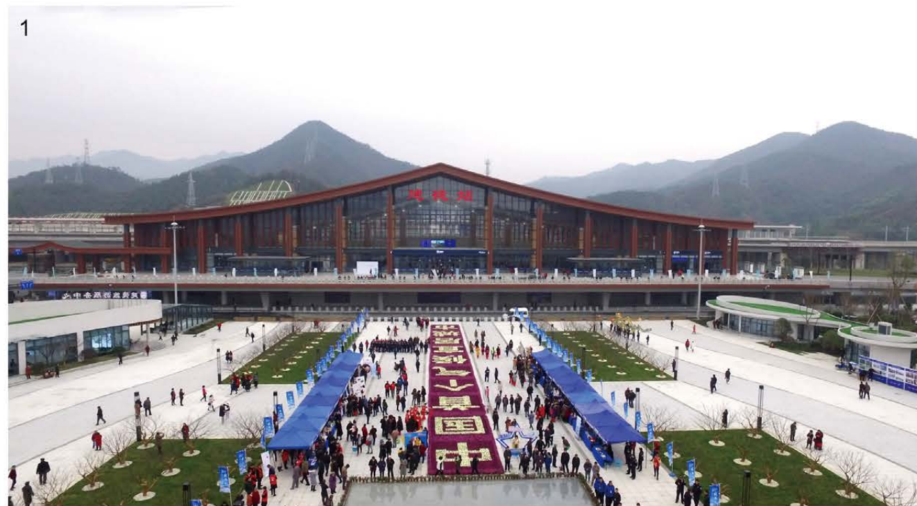
1 杭黄铁路建德东站连接线及站前广场 PPP 项目实景图
